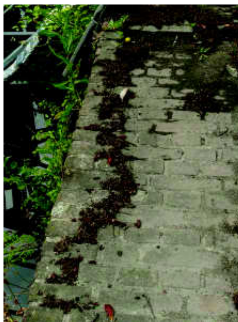
Straatvuil spoelt met regenwater over de muur.
