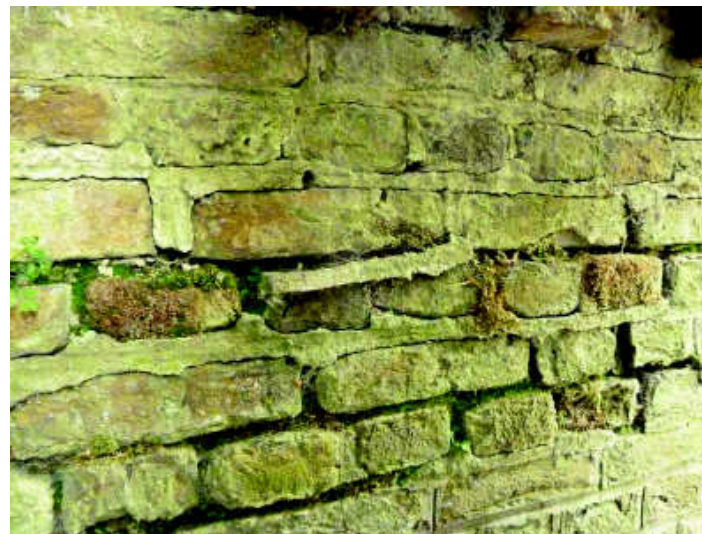
Vorstschade door gebruik van te harde mortel.
