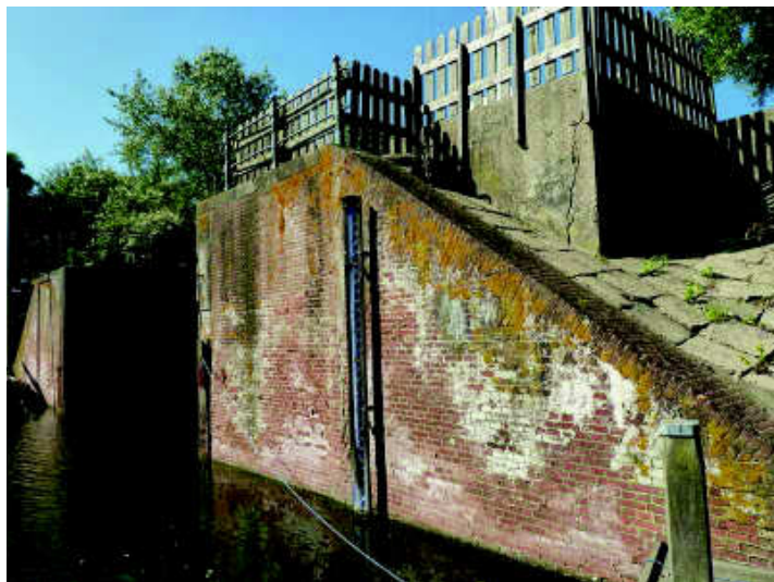
Alleen de brughoofden zijn met baksteen opgemetseld.
