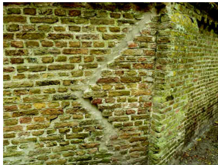
Kalkmortel is elastisch en kan verzakking van de muur ten dele opvangen.
