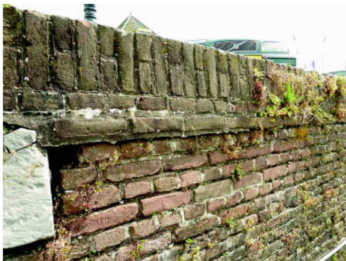
Muren in slechte staat met veel barsten in de lengterichting.
