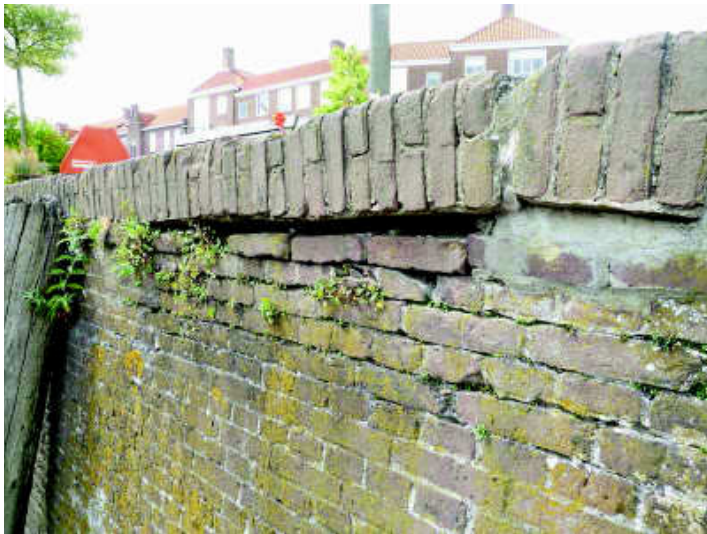
Plaatselijk is de muur in zeer slechte staat. Klein glaskruid profiteert van de scheuren in het metselwerk.
