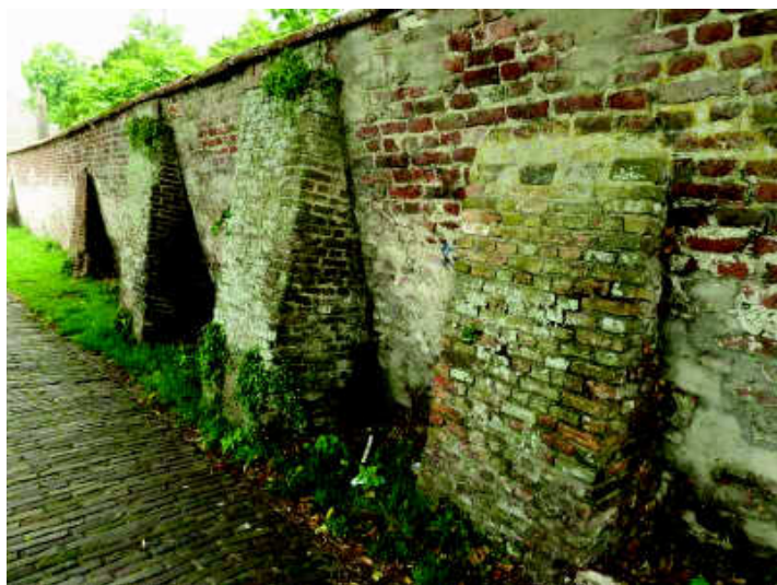
Oude gemetselde steunberen houden de muur voorsnog overeind.
