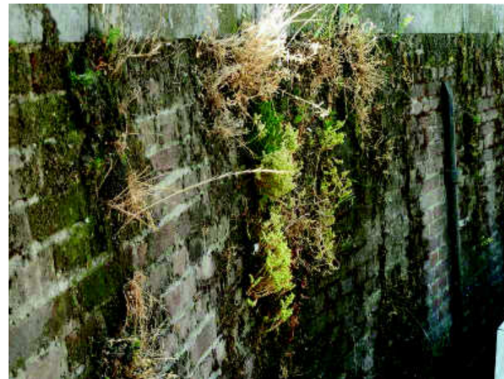
Straatvuil spoelt over de muur en plakt in grove plakkaten aaneen.
