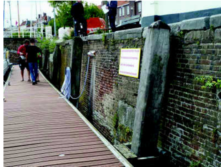
Vanaf het plankier zijn de muren goed te bekijken.
