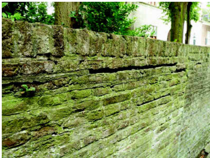
Er is gevoegd met harde specie waardoor het vocht in de muur niet weg kan. Door vorstschade komt de voeg los.
