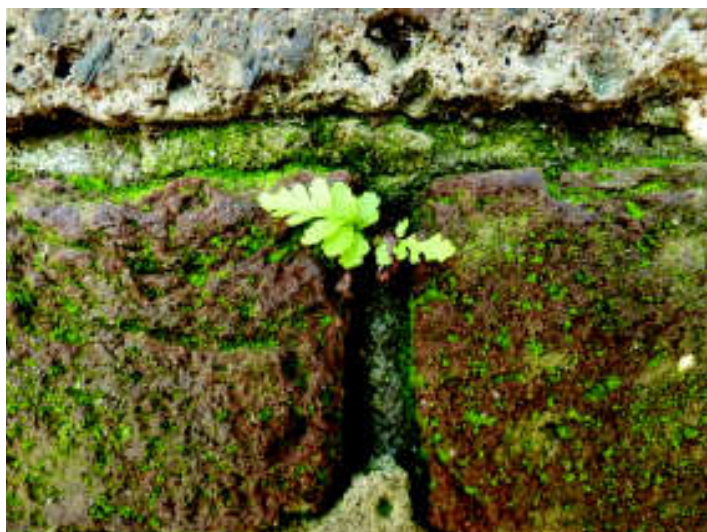
Nadat de muren werden schoongespoten groeien enkele varentjes terug uit.
