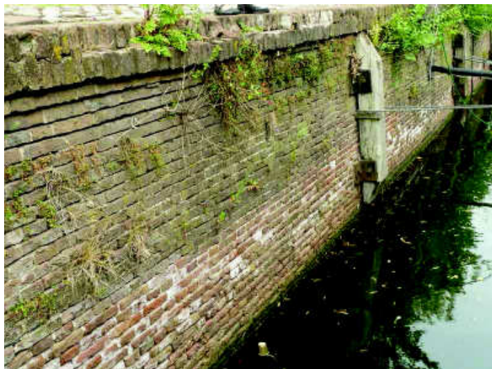
Stenen brokkelen af aan de bovenrand.
