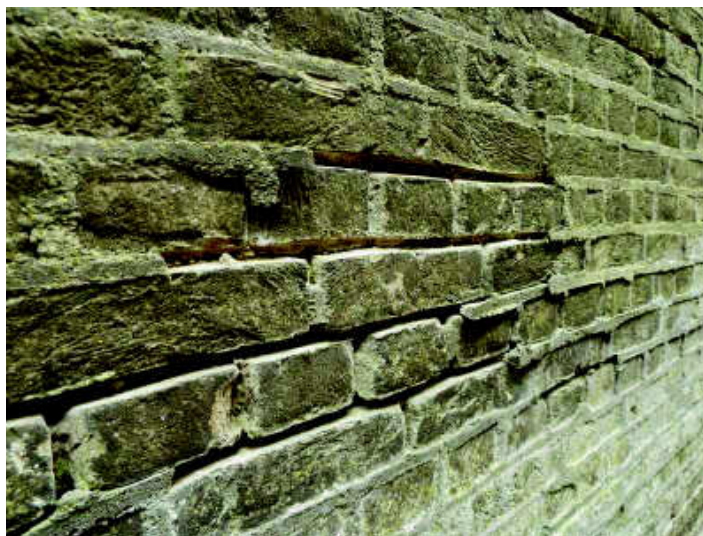
Er is gevoegd met harde specie waardoor het vocht in de muur niet weg kan. Door vorstschade komt de voeg los.
