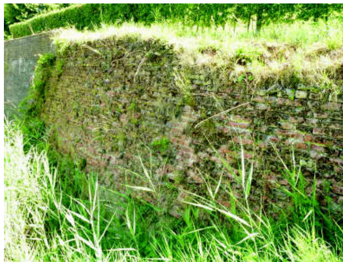
Enkele stukken muur zijn opgemetseld met gewone bakstenen, maar wel met harde cement..
