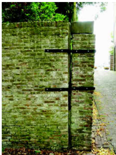
Er is gevoegd met harde specie waardoor het vocht in de muur niet weg kan. Door vorstschade komt de voeg los.
