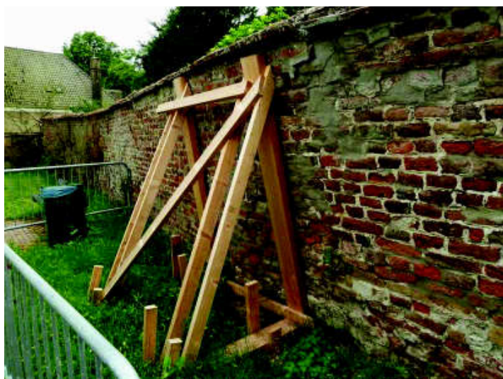
Deze tijdelijke constructie zou snel vervangen moeten worden door een degelijke gemetselde steunbeer.
