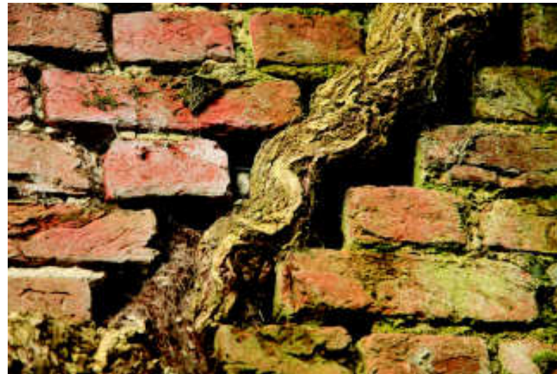
Van groot belang is het tijdig verwijderen van houtige gewassen. In dit geval heeft een vlier gebruik gemaakt van een spleet in de muur. Door de diktegroei van de stam wordt de muur compleet ontzet (vervallen huis in Westdorpe).
