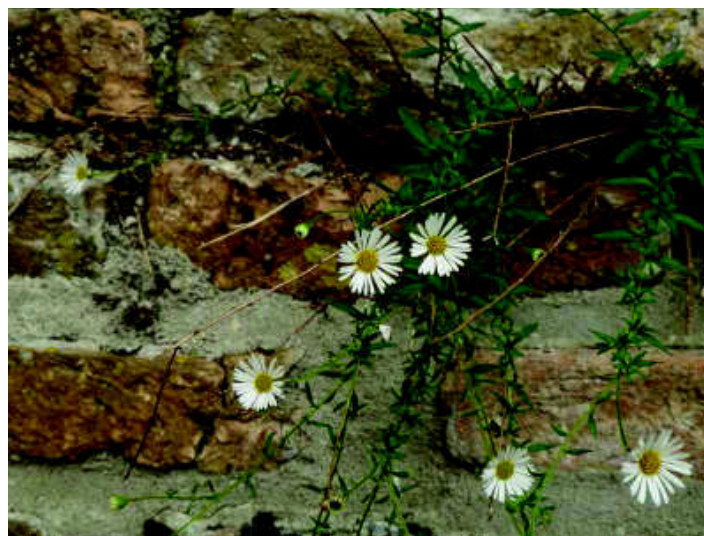
Bij de grootschalige restauratie is onder meer muurfijnstraal behouden gebleven.
