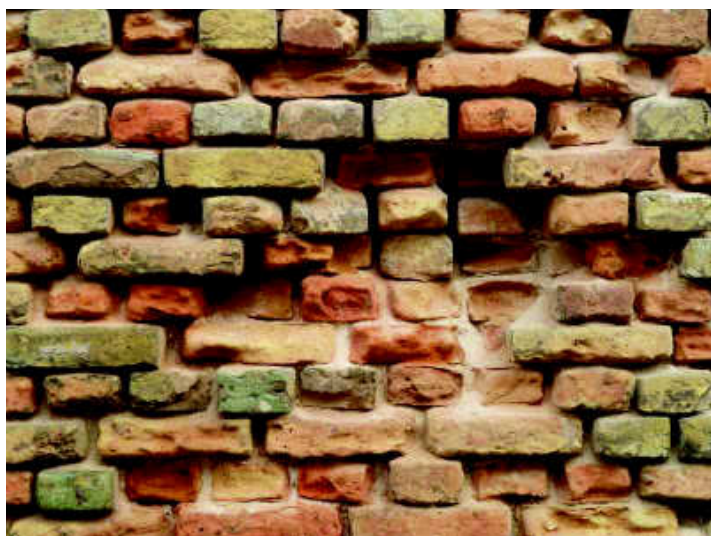
Zowel de stenen als de zachte kalkmortel is sterk verweerd.
