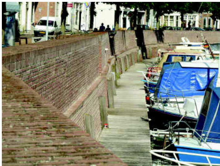
Nieuwe stenen en harde specie werden gebruikt bij de restauratie.
